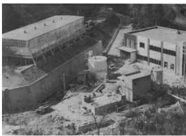
工事中的上田浄水場 (昭和54年3月)
