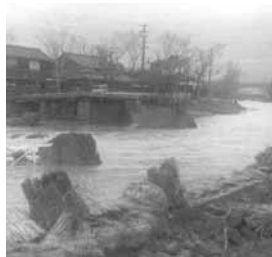
集中豪雨で流失した中 所橋(榎列掃守) (昭和40年9月)
