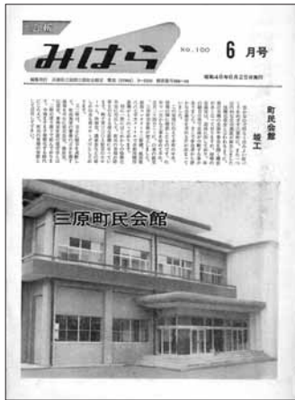
町民会館の竣工を伝える記事。1階には椅子席で300人が収容できるホールと2階には騒音を遮断した議場や委員会室を備えています
